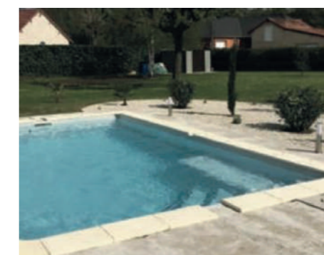
8. Pose des margelles
